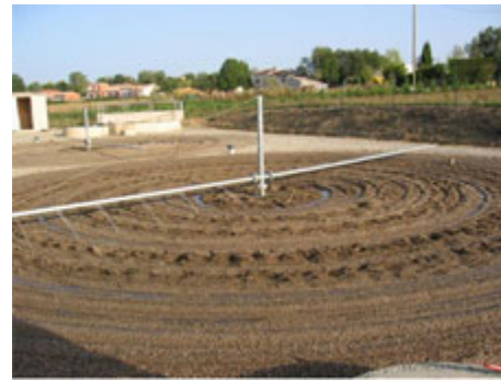
2) Massif filtrant de la station de Mazens
