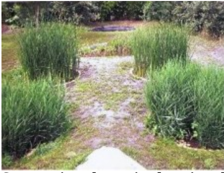
Succession de petits bassins d'épuration naturelle par des plantes Photo Eau et habitat / Mr et Mme Billet
