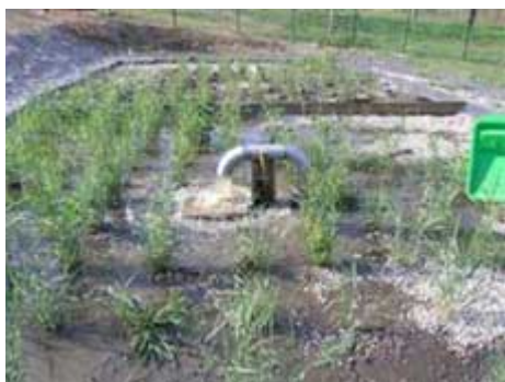
Alimentation par débordement "clos de cygne" via un réseau sous-terrain
