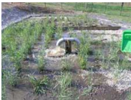
Alimentation par débordement "clos de cygne" via un réseau sous-terrain
