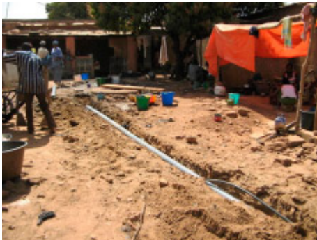
Construction d'un réseau à Bamako
