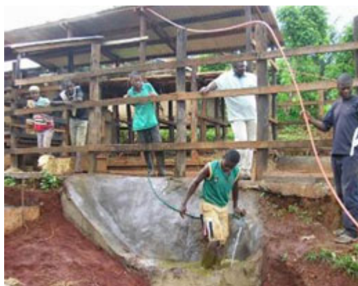
Remplissage d'un méthaniseur avec des bouses de vaches diluées dans un autre projet Biogaz en Afrique. Photo Eric Florantin Tankeu
