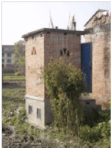
Latrine à 2 fosses surélevées Photo WELL
