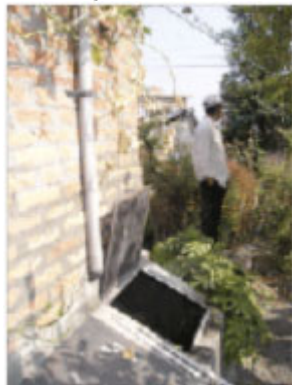
Latrine à compartiment. Photo CREPA
