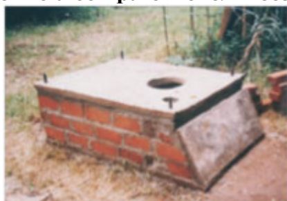
Fabrication d'une dalle et d'un compartiment. Photo CREPA
