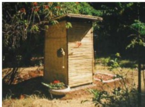
Latrine à 2 fosses à structure légère amovible - Photo CREPA
