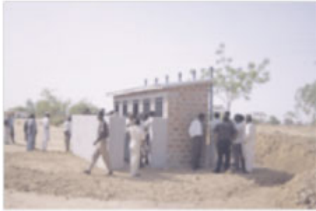
Latrine communale au Nigéria. Photo WEDC
