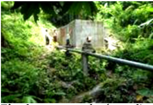
Tête de captage et de réseau d'eau gravitaire au Laos (Photo UN Habitat)
