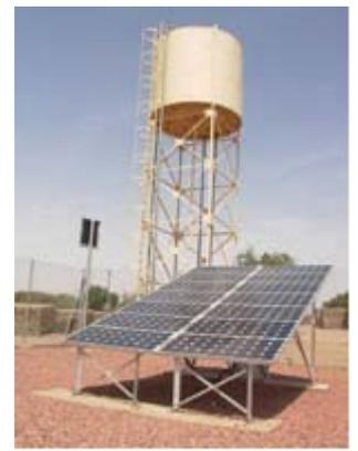
3) **Au Sénégal**, la réalisation en 2007 d'un réseau hydraulique complet dans le village de Diabal d'environ 1000 habitants (forage à 70 m, pompe solaire, réservoir, 3 km de canalisations, 6 bornes **fontaines** + création d'une coopérative maraîchère) avait coûté 46 000 € tout compris.
