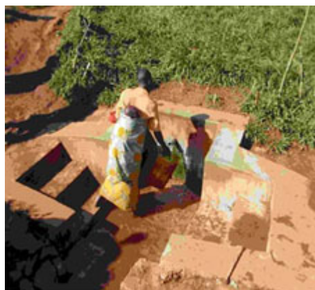
Captación de agua en un manantial de Burundi (fotografía:Caritas Burundi)
