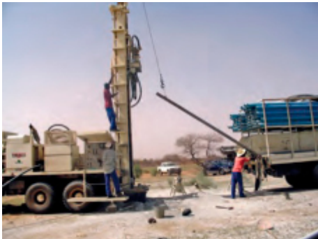
Plataforma de perforación sobre un camión - Foto AFD
