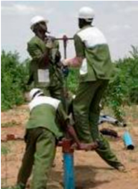
Perforación con ahoyadora.
