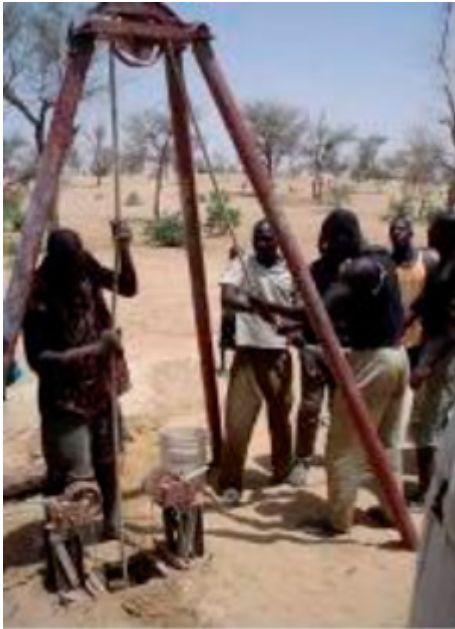
Photo fondation practica [forage->spip.php&nbsp; ; ?mot50] à la percussion
