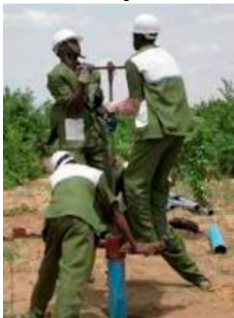
Forage à la tarière Photofondation practica
