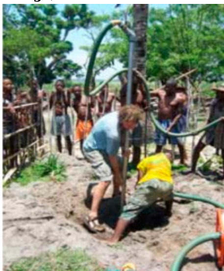
forage d'un puits à madagascar par la méthode dite du « jetting » Photo PS Eau
