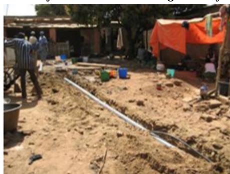
Instalación de una tubería en Malí
