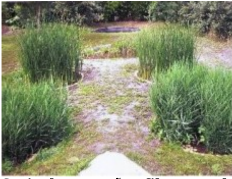
Serie de pequeños filtros verdes de depuración natural - Foto Eau et habitat / Sr y Sra Billet
