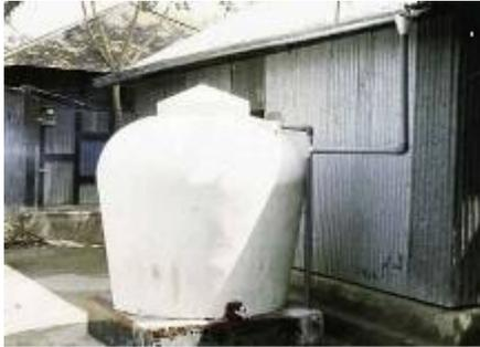
Depósito de ferrocemento
