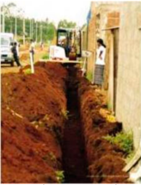
Instalación de una red pública en Brasil. Foto Melo.
