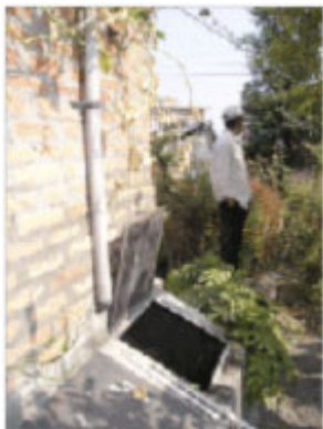
Letrina con cámara. Foto CREPA
