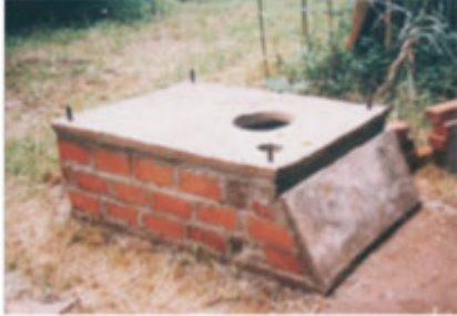
Fabricación de una losa y una cámara. Foto CREPA
