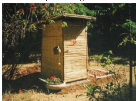
Letrina de dos pozos con estructura ligera amovible - Foto CREPA
