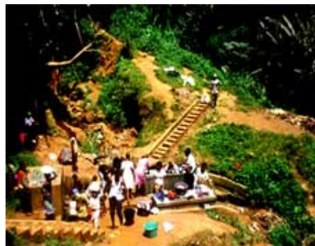
Captage et aménagement de source avec lavoirs à Yaoundé (Cameroun) (Photo C.Le Jallé PSEau)
