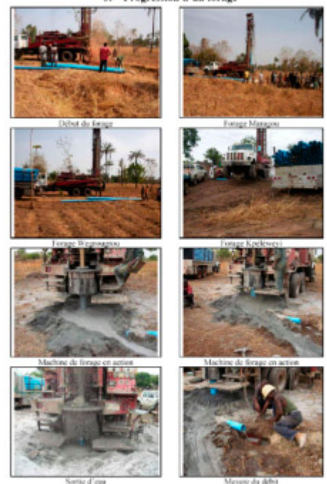
Annexe 5. Progression d'un forage
