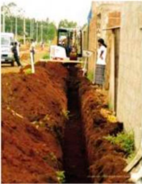
Installation d'un réseau public au Brésil. Photo Melo. ❌
