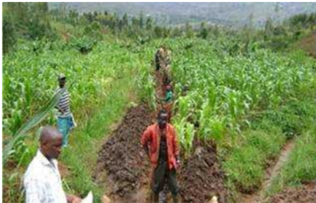
Creusement par les villageois d'une tranchée pour adduction d'eau au Burundi. Photo Caritas Burundi
